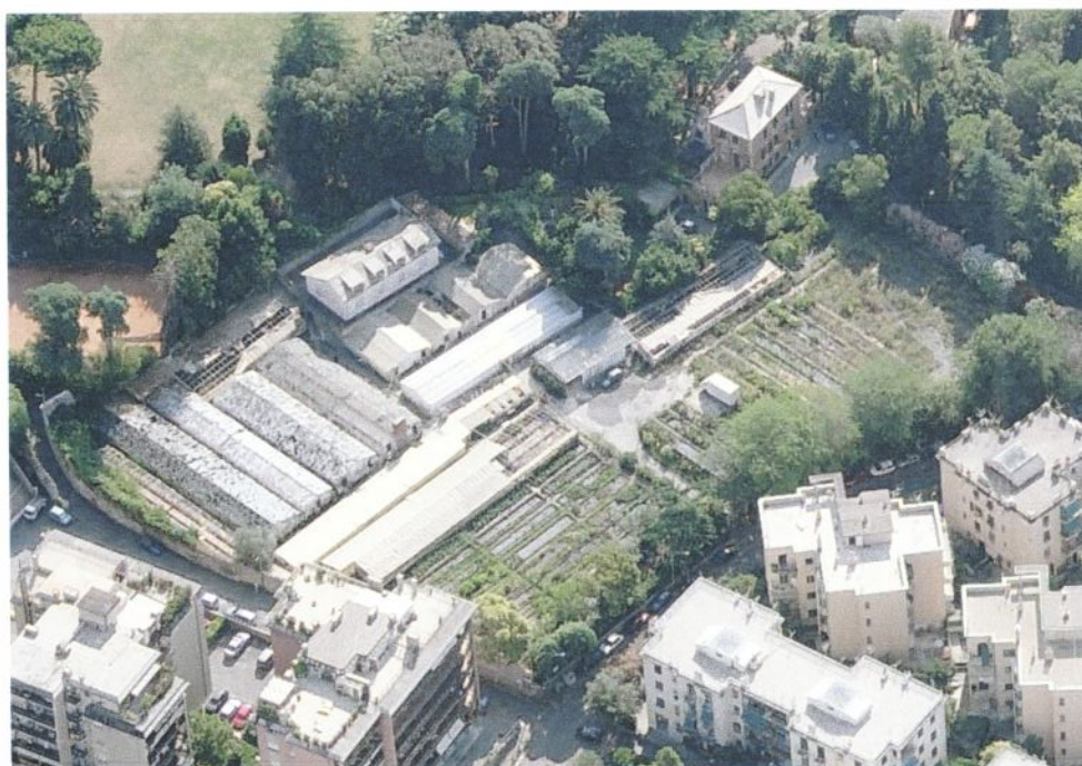
Foto 4: vista dell'area serre da sud-ovest
