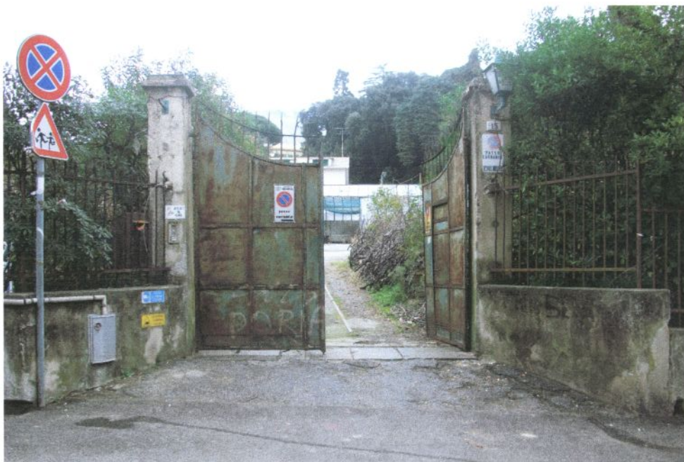
Foto 8: l'accesso alla proprietà da Viale Pio VII n°15
