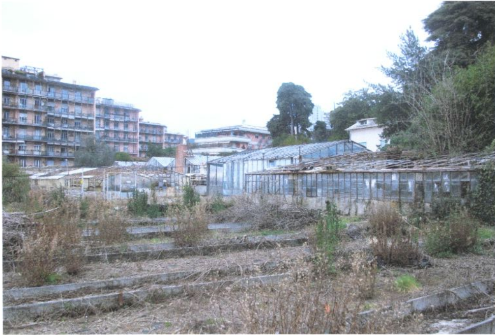
Foto 9: vista sulle serre fatiscenti
