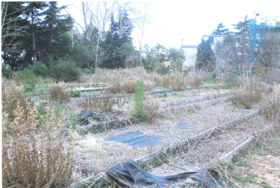
Foto 12: vista sulle superfici cementificate
